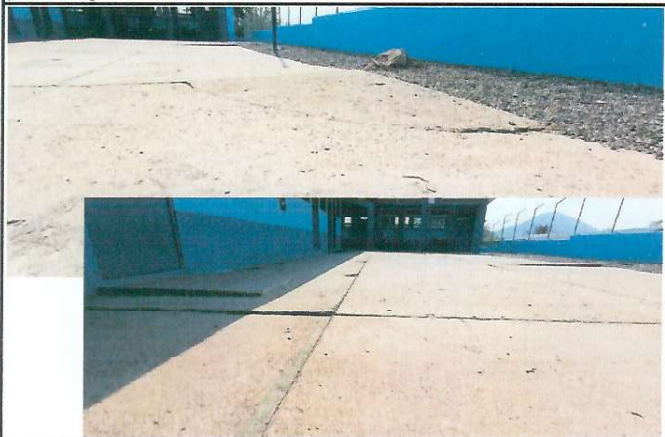
Foto 3: La losa del patio deportivo está rajado y levantado debido a las raíces de 2 Ficus -ya eliminados-. Las áreas dañadas representan riesgo para la comunidad educativa.
