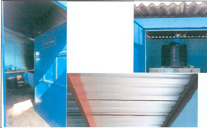
Foto 1: Reemplazar láminas de la cocina, reemplazar techo del lavadero, y colocar tornillos en todos los traslapes de las láminas del techo de los salones de clase, que presentan goteras.
